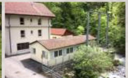
**Les centrales au fil de l'eau** – l'eau est prise directement de la rivière (à l'amont), l'eau descend, tourne les turbines, et rentre à la rivière – c'est le système actuel dans l'Avançon de Bex
