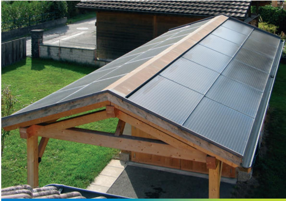
Les panneaux photovoltaïques font aussi office de toiture lors de rénovation ou de nouvelle construction.
